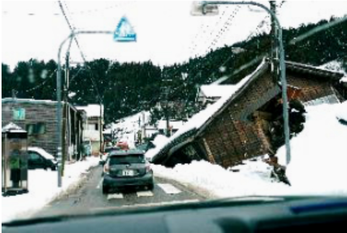
能登半島地震で倒壊した家屋
